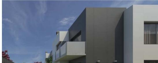
Fachada principal: Cerramiento de fachada compuesto por doble hoja de ladrillo cerámico, cámara de aire y aislamiento térmico con planchas rígidas de espuma de poliestireno extruido, machihembradas y revestimiento exterior con baldosa de gres porcelánico Ston-Ker de SALONI, de 37,3x37,3 cm., colocadas mediante el sistema FP de Butech, con juntas de 5 mm. de ancho mínimo, sobre soporte enfoscado con mortero, recibidas con mortero cola y anclaje mecánico metálico.
