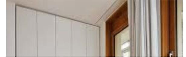
Frentes de armario empotrados, con hojas lisas de 30 mm. de espesor (A/MLM) de roble barnizado, con precerco de pino macizo 70x35 mm. galce de roble de 70x30 mm., tapajuntas exteriores moldeados de DM rechapados de roble 70x10 mm., tapetas interiores contrachapadas de pino 70x4 mm., herrajes de colgar, imanes de cierre y tiradores.
