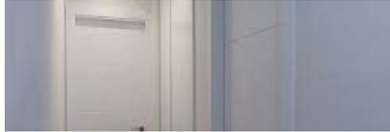
Puerta de entrada practicable de 1 hoja ciega y fijo acristalado, de composición mixta, exterior de aluminio lacado e interior de madera barnizada de 145x215 cm., compuesta por cerco, hoja de panel sandwich con aislamiento interior, resbalón con cerradura y manilla ambos lados, cremona con cuatro puntos de cierre y tres bisagras, instalada sobre precerco de aluminio y solapa interior de madera.
